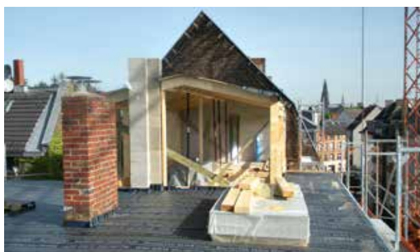
Baustelle mit Dom
